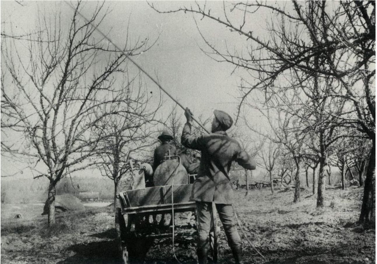
Besprutning av fruktodlingar vid Tomarp, maj 1915. På bilden syns Sveriges första besprutningsaggregat – den Teme-Möllerbergiska sprutan. Foto: troligen Carl Möllerberg; ur Stina Sandström-Möllerbergs album.
